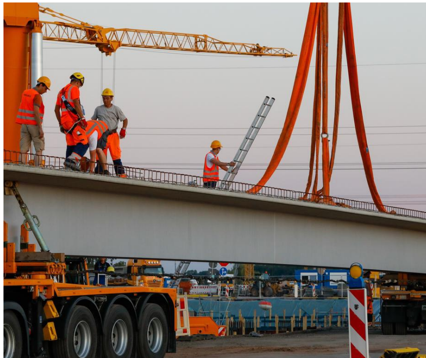
Autobahn GmbH construction. (Image: Torsten Hanspach)
