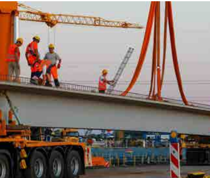
Autobahn GmbH construction. (Image: Torsten Hanspach)
